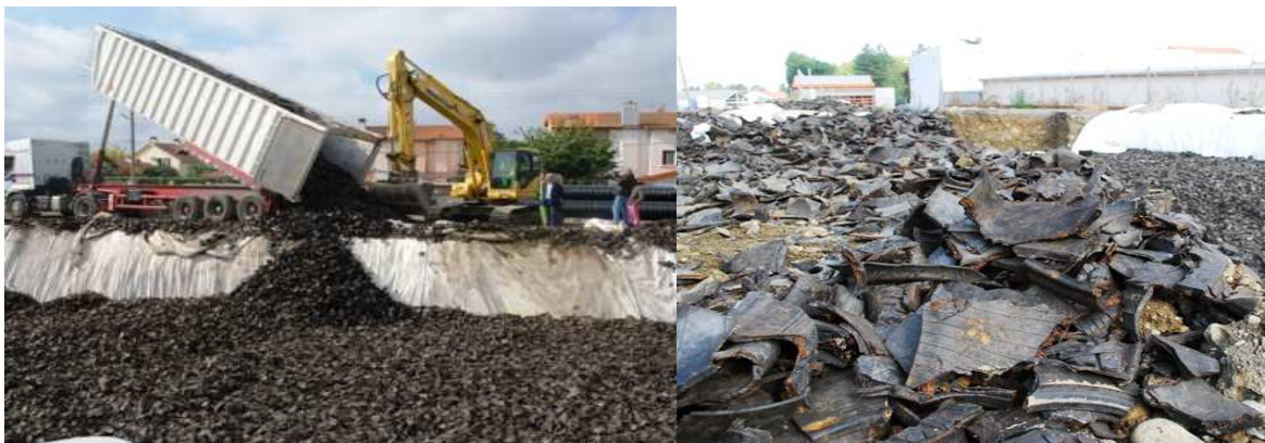
Figure 1 : Bassin de rétention du parc industriel ALSTOM près de Tarbes (à gauche : déchargement des broyats de pneus sur la géomembrane ; à droite : détail des broyats de pneus) [source : www.legrandtarbes.fr]
