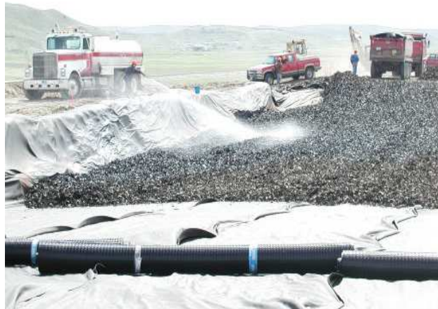
Figure 8 : Mise en place des broyats de pneus (humidification avant compactage)
